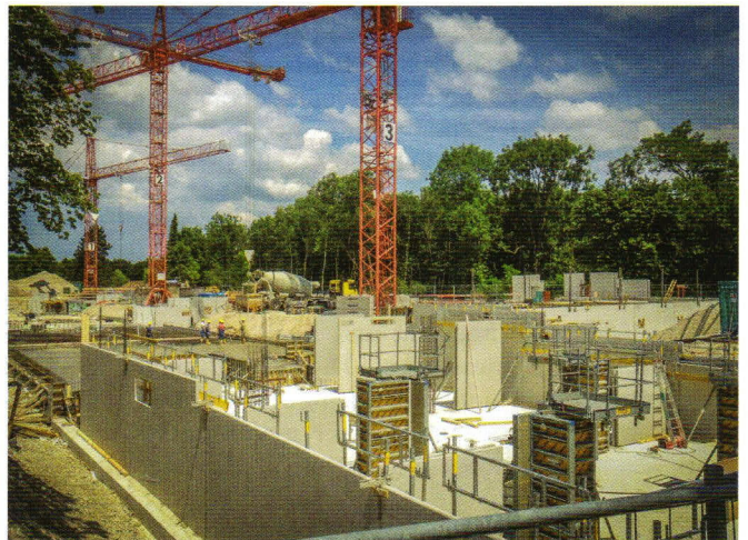
Die Planung und Fertigung der SySpro-Doppelwandelemente erfolgen immer objektbezogen. Abb.: GM Objekt München B GmbH / Erich Spahn
